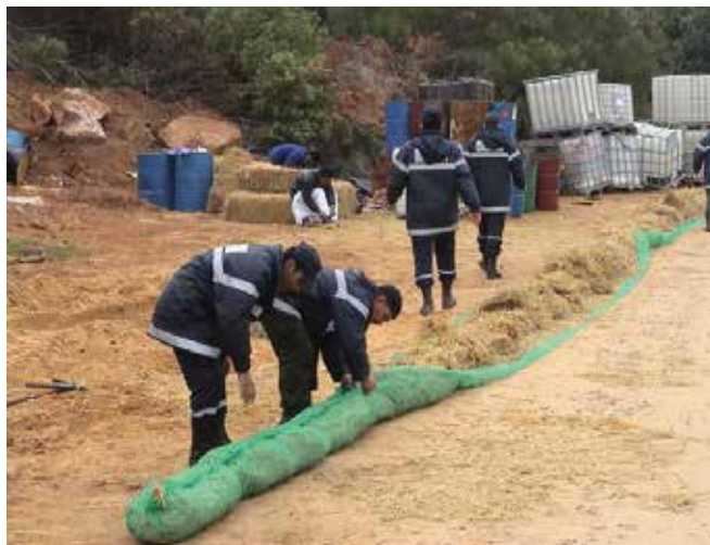
▲ Рис. 20: Импровизированный бон, собранный из сетки и соломы. Такой бон вряд ли продержится дольше одного приливо-отливного цикла, тем не менее, он снизит загрязнение береговой линии от поступающей плавающей нефти.
