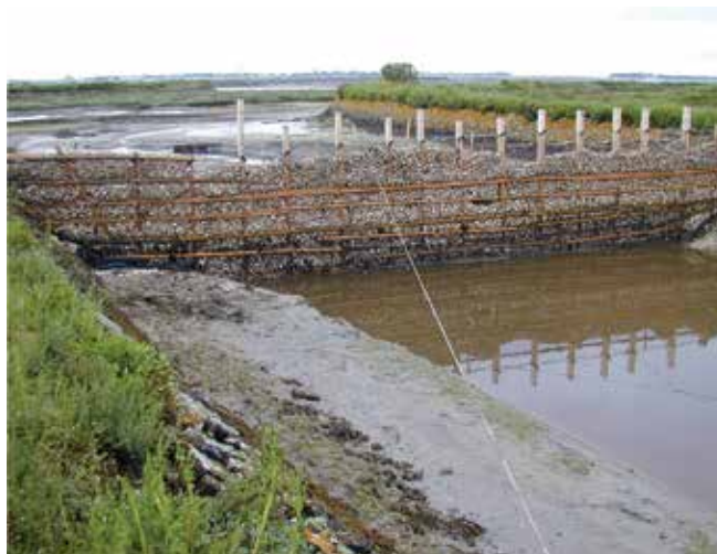
▲ Рис. 21: Барьер, построенный из устричных раковин и удерживаемый стойками и сеткой.
