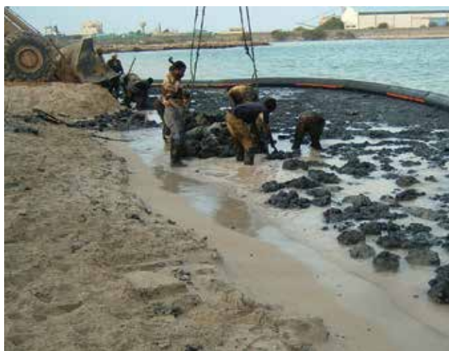
▲ Рис. 19: Для облегчения сбора полутвердая нефть удерживается у береговой линии секцией надувного бона.
