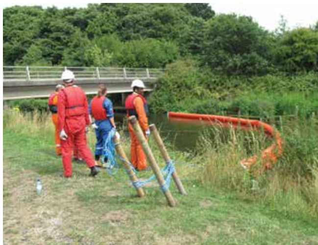
▲ Рис. 17: Якорные стойки для удерживания бона на месте на береговой линии, не имеющей деревьев или других объектов, пригодных для крепления бона.
