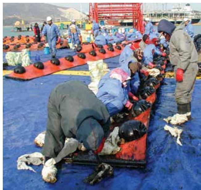
▲ Рис. 6: Нефть, захваченная за внешними поплавками бона-ограждения, может особенно трудно поддаваться очистке.
