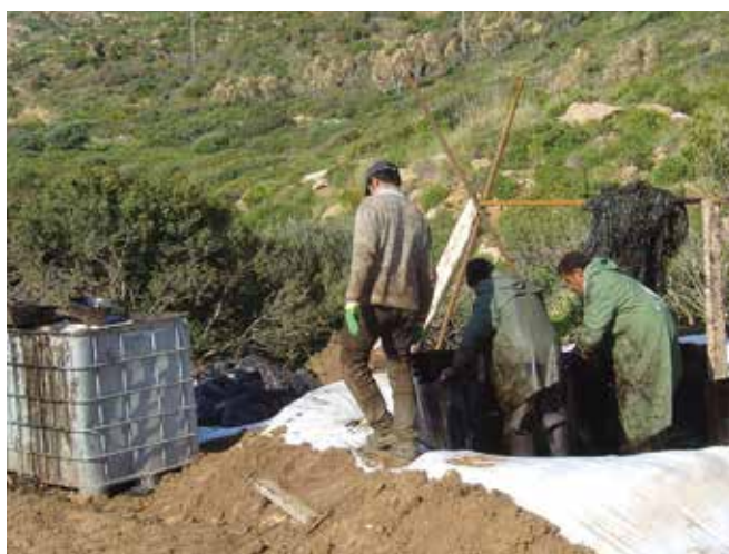
▲ Рис. 16: Насыщенная сорбентная ловушка, вывешенная на столбе для стока нефти в контейнер с целью снижения количества несвязанной нефти в отходах.
