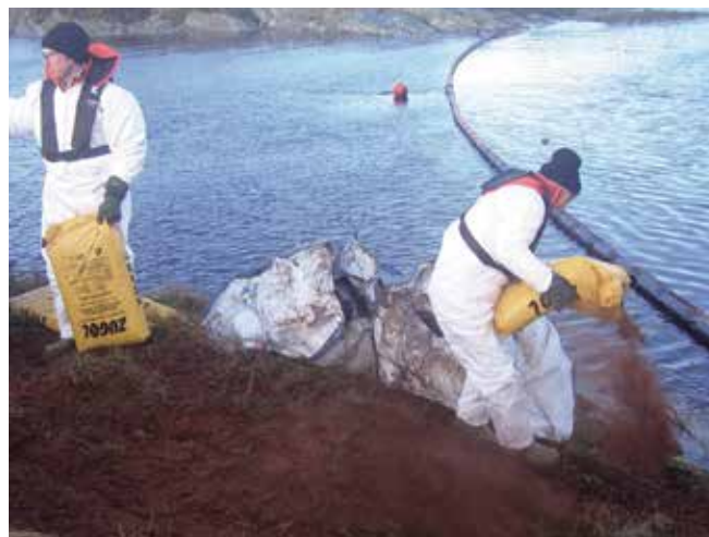
▲ Рис. 10: Сорбенты из органических частиц, таких как торф или кора, могут наноситься на скальные берега, имеющие важное значение для животных (например, пингвинов и котиков) для уменьшения загрязнения их меха и перьев при выходе на берег.
