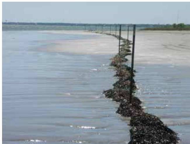
▲ Рис. 7: Ловушка, протянутая через дельту реки для улавливания плавающей нефти. Открытая конструкция и большая площадь поверхности материала являются особенно подходящими для сбора вязких нефтепродуктов.
