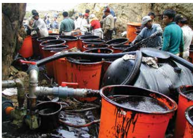
▲ Рис. 13: Собранная на скалистой береговой линии нефть помещается на временное хранение в большие контейнеры с открытым верхом. Для перекачки этой нефти на верх отвесной скалы и затем в вакуумные машины потребовались насосы.
