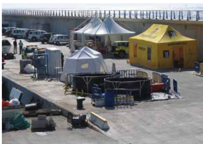
▲ Рис. 45: Временные сооружения, расположенные поблизости от рабочей территории, предназначены для организации питания и санузлов для персонала.
