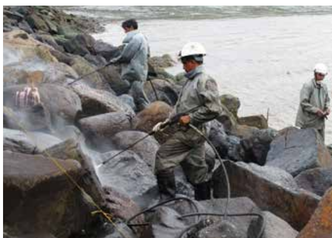
▲ Рис. 32: Очистка каменной наброски промывкой под высоким давлением.
