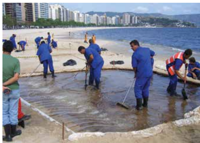
▲ Рис. 16: Нефть, погруженная в песчаный пляж, смывается водой под низким давлением, подаваемой по шлангам и перфорированным трубам. Нижний слой также взбалтывается вручную, чтобы вызвать отделение нефти от песка. После этого нефть собирается сорбирующим бонем, окружающим рабочий участок.
