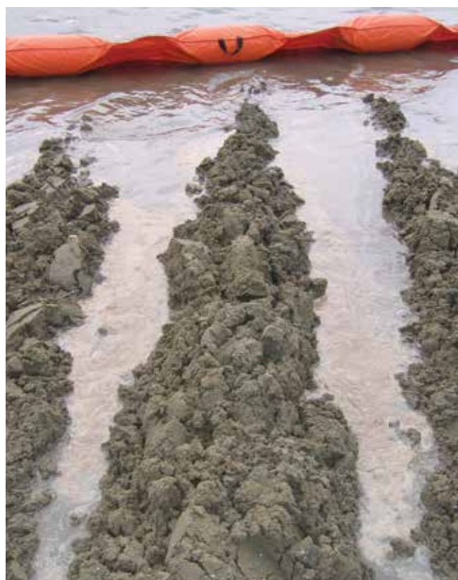
▲ Рис. 25: Загрязненный пляжный грунт выводится на поверхность вспашкой. После этого нефть высвобождается из грунта при последующем приливе, и ее можно собрать у кромки воды.
