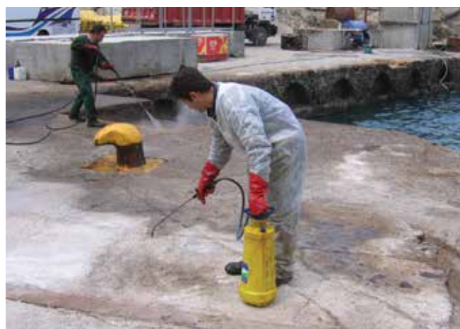
▲ Figure 23: Нанесение химического чистящего вещества на нефтяное пятно с последующей промывкой под высоким давлением.
