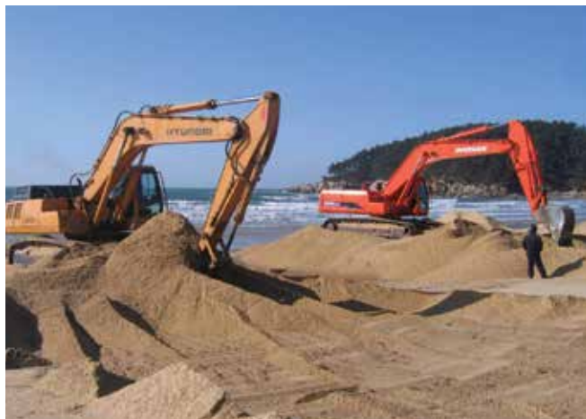
▲ Рис. 18: Легкозагрязненный песок перемещается в волноприбойную зону для смыывания при последующих приливах.
