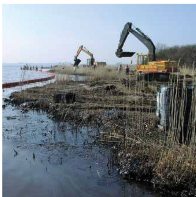
▲ Рис. 41: Использование тяжелого машинного оборудования на экологически уязвимых участках береговой линии может нанести значительный дополнительный ущерб. В этом случае приоритетной задачей являлась необходимость быстрого сбора плавающей на поверхности нефти.
