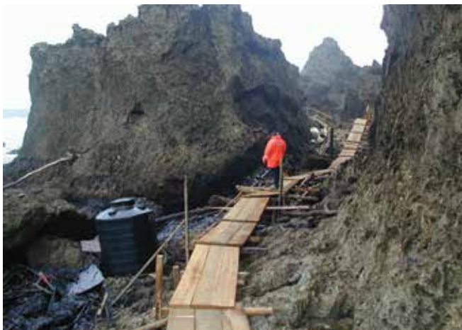
▲ Рис. 35: Для снижения опасности для рабочих на скалистых береговых линиях могут строиться временные пешеходные настилы.
