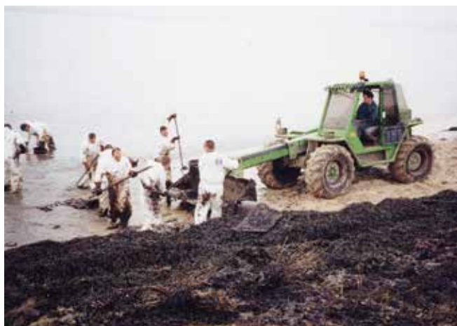
▲ Рис. 8: Ручной сбор нефти и замасленных морских водорослей в телескопический ковш. Такой метод позволяет собирать загрязненные нефтью отходы в предпочтение чистому материалу, что снижает количество отходов.
