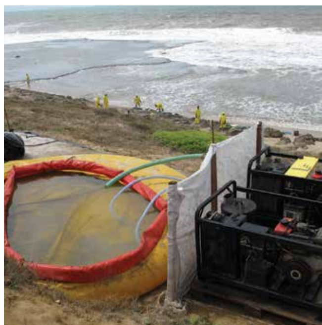
▲ Рис. 22: Очистка под давлением уступа скальной породы на отдаленной территории. Морская вода была закачана в резервуар временного хранения для последующего использования расположенными поблизости нагнетательными машинами высокого давления.
