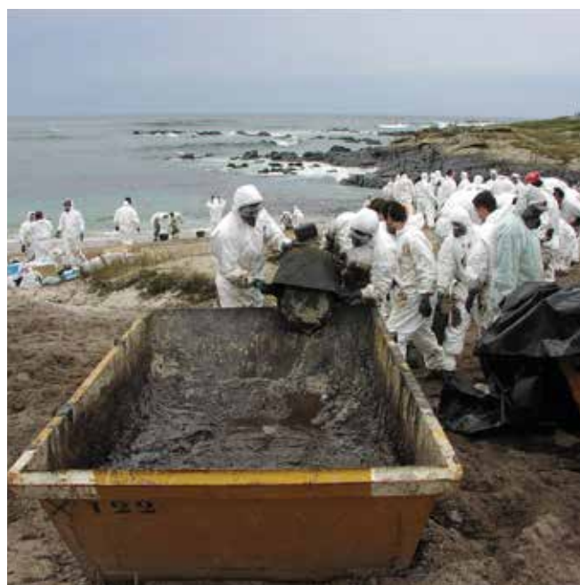
▲ Рис. 15: Цепочка рабочих, опорожняющих ведра с нефтью и замасленным материалом пляжа в сип, используемый для временного хранения.
