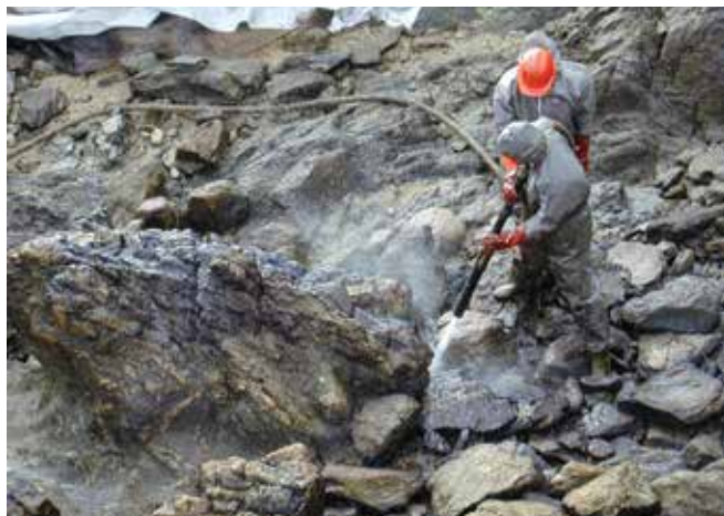
▲ Рис. 17: Вода низкого давления используется для вымывания нефти из промежутков между скальными породами, чтобы быть собранной сорбентом на береговой линии.
