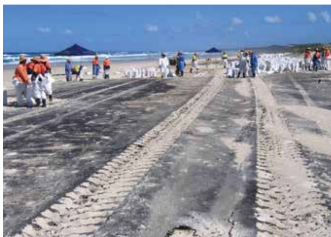
▲ Рис. 6: Использование машин на загрязненных нефтью береговых линиях может привести к дополнительному загрязнению. В данном случае тракторы, проехавшие по нефти, задавили нефть вглубь пляжа.
