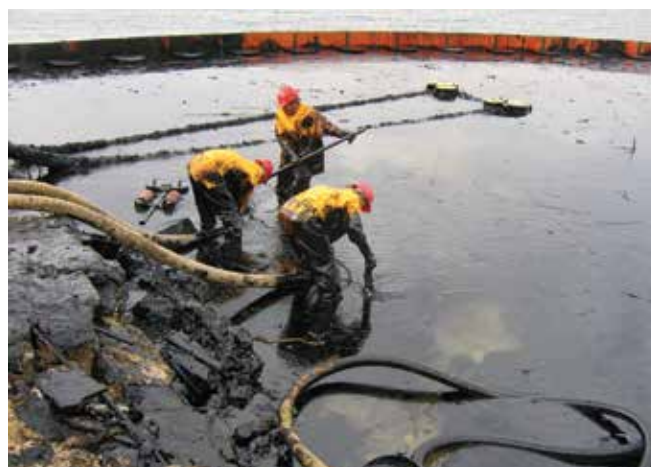
▲ Рис. 3: Удаление жидкой разлитой нефти с береговой линии с помощью скиммера по типу швабры и вакуумных насосов.
