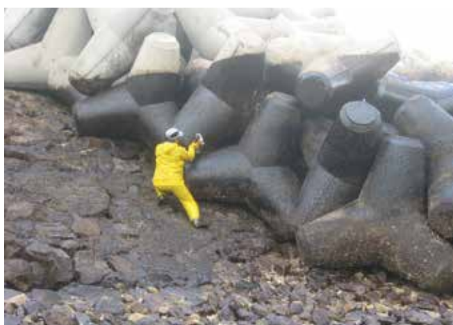
▲ Рис. 33: Очистка замасленных тетраподов затруднительна ввиду трудности доступа к нефти внутри конструкции.
