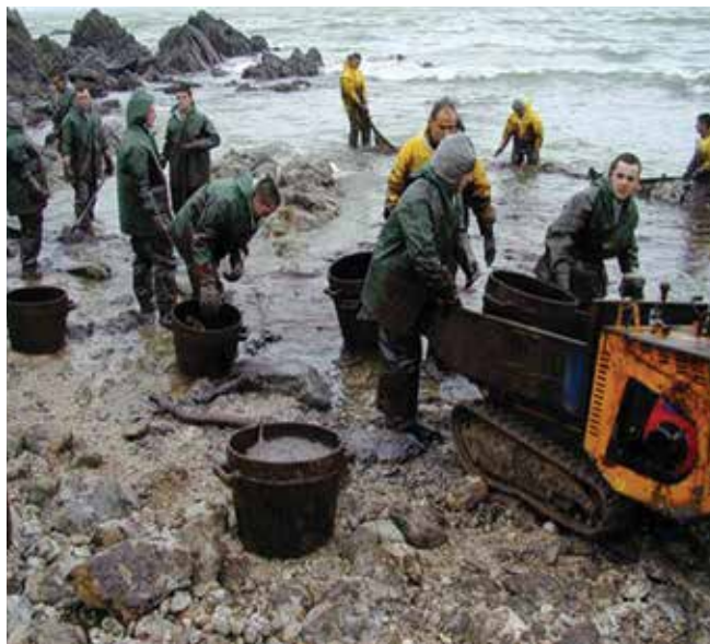
▲ Рис. 1: Ручной сбор основного объема разлитой нефти. Применение ручного труда для избирательного сбора нефти с береговой линии снижает количество собранного незагрязненного материала.
