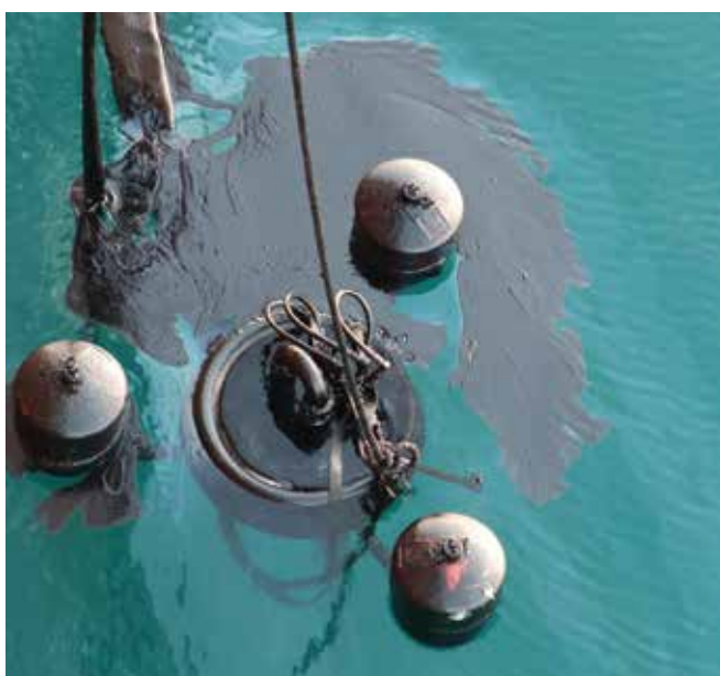
▲ Рис. 10: Рабочие размещают рукав, соединенный с вакуумным насосом, непосредственно в нефтяной слой. В этом случае небольшая водосливная приставка была снята, чтобы дать возможность вязкой топливной нефти затечь в рукав. В результате забор воды может увеличиться.
