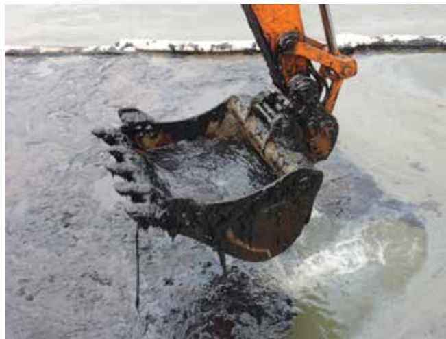
▲ Рис. 21: Применение экскаватора для сбора высоковязкой топливной нефти. Концентрация собираемой нефти была повышена выдачей оператору инструкции о том, чтобы короткое время удерживать ковш над поверхностью, давая стечь забранной воде. Это снизило затраты на последующую утилизацию за счет эффективности сбора.
