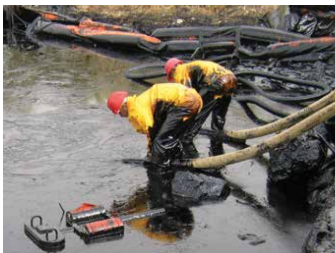
▲ Рис. 10: Рабочие размещают рукав, соединенный с вакуумным насосом, непосредственно в нефтяной слой. В этом случае небольшая водосливная приставка была снята, чтобы дать возможность вязкой топливной нефти затечь в рукав. В результате забор воды может увеличиться.
