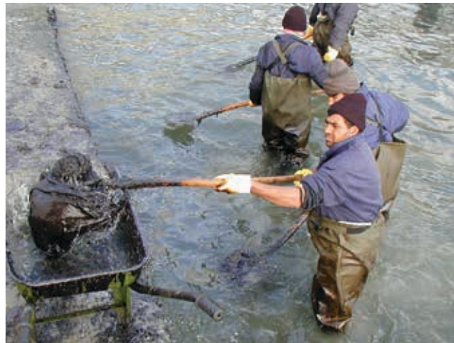
▲ Рис. 9: Устранение опустившейся на дно тяжелой топливной нефти вручную.
