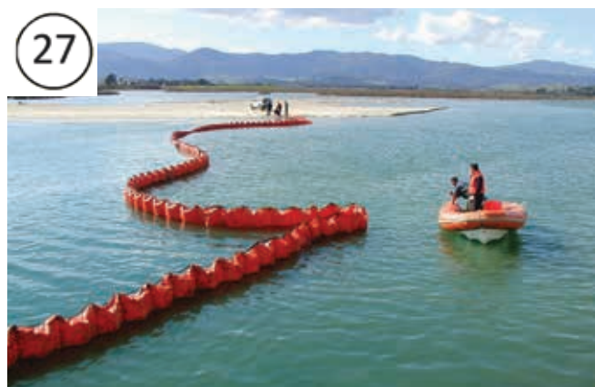
Рис. 5: Установка бонового заграждения возле устья реки. Бонное заграждение разворачивается с целью направить нефтяное пятно к пункту сбора нефти с хорошим доступом с берега.
