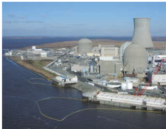
▲ Рис. 7: Необходимо принять меры для защиты водозаборных сооружений и предотвращения попадания нефти в теплообменники, которые сложно поддаются очистке. Их выход из строя может привести к прерыванию эксплуатации объекта.
