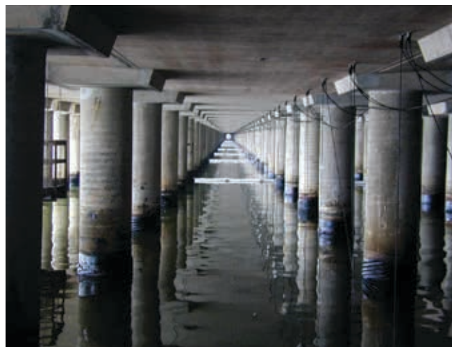
▲ Рис. 5: Ввиду ограниченной высоты рабочего пространства и недостаточной вентиляции условия проведения работ по очистке участка под причалами могут быть сложными и опасными.
