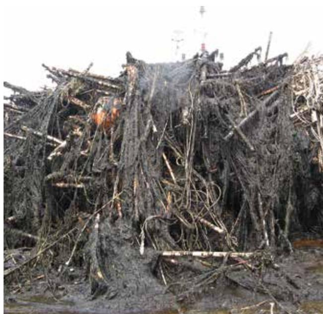
▲ Рис. 12: Сильно загрязненные стойки для выращивания морских водорослей. Они не могли быть очищены до удовлетворительного состояния и поэтому были демонтированы и заменены новыми конструкциями.
